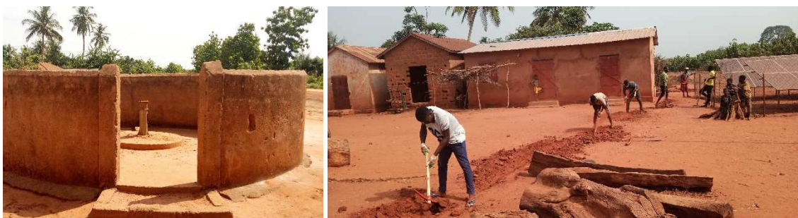
Rénovation du forage et installation du réservoir d'eau
