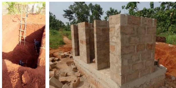
Construction des latrines scolaires
